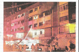
PASUKAN bomba memadam kebakaran di tingkat empat bangunan di Jalan Pantai Berahi, Petagas, Putatan.
