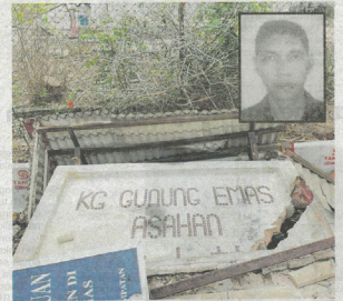
Tembok konkrit terata nama kampung runtuh dan menghempap Nazri yang sedang melakukan kerja-kerja perparitan.
