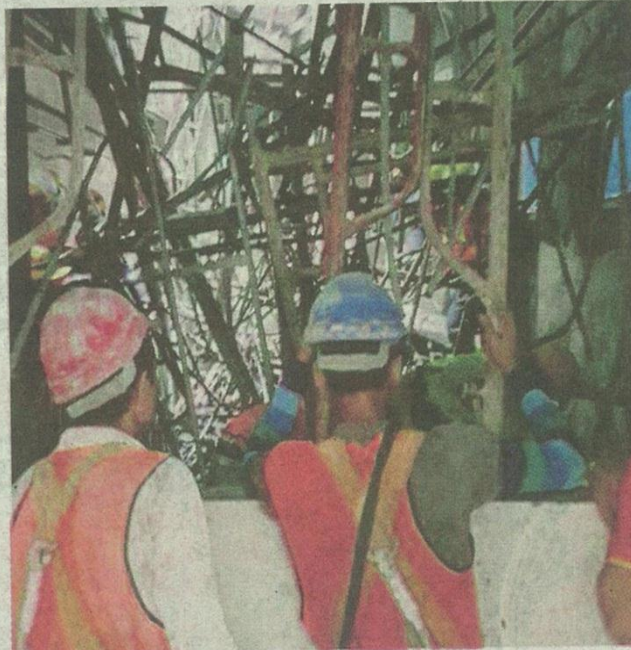
PEKERJA binaan membantu mengalihkan besi perancah yang jatuh.
