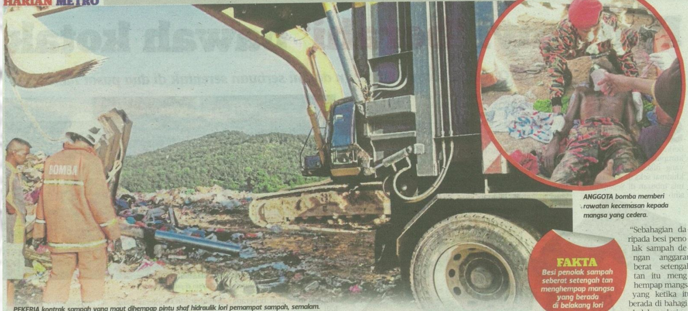
PEKERJA kontrak sampah yang maut dihempap pintu shaf hidraulik lori pemampat sampah, semalam.
