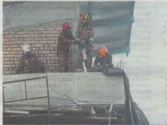
Anggota bomba menggerudi konkrit untuk mengeluarkan mangsa dalam runtuhan di Kampung Baru Balakong.
