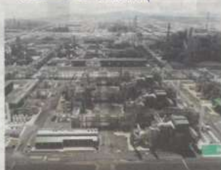
GAMBAR fail menunjukkan struktur projek yang terdapat di dalam kawasan Rapid Pengerang.
