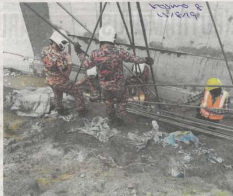
ANGGOTA bomba mengalihkan timbunan besi cerucuk untuk mengeluarkan mangsa di sebuah tapak pembinaan di Petaling Jaya semalam.
