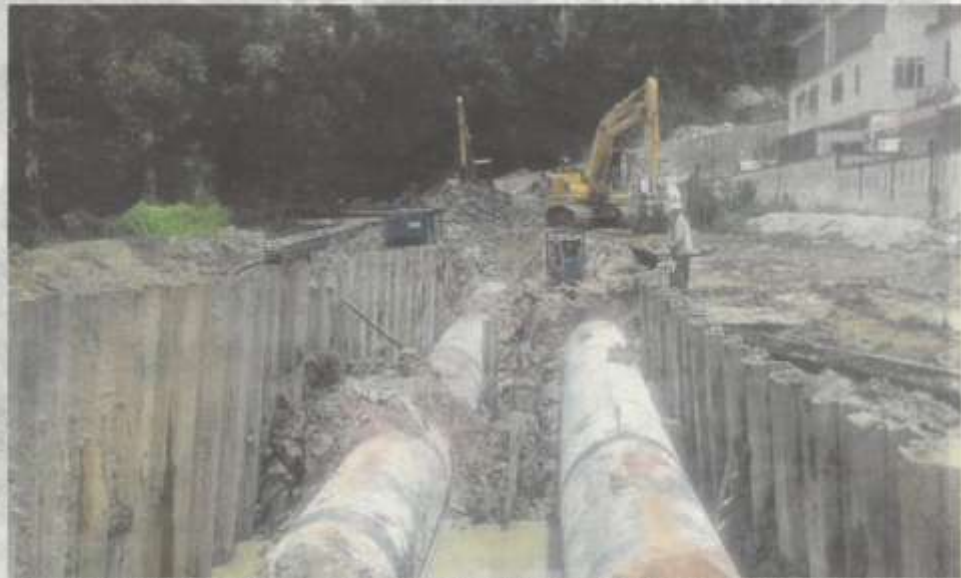
Lokasi Kon Sin tertimbus ketika memasang paip bawah tanah di Jalan Permatang Pasir-Bukit Jugra, Banting, pagi semalam.
